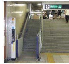
■ 車椅子階段昇降機 (烏丸御池駅)
