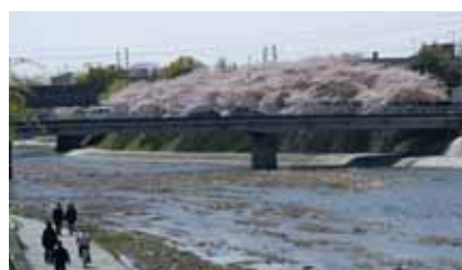
鴨川・塩小路橋
