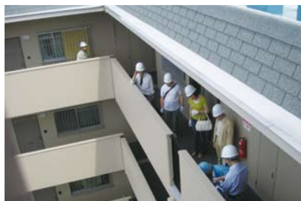
計画修繕に取り組む分譲マンション
