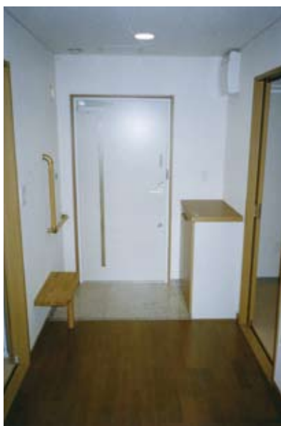
手すり、段差解消が施された高齢者向け優良賃貸住宅
