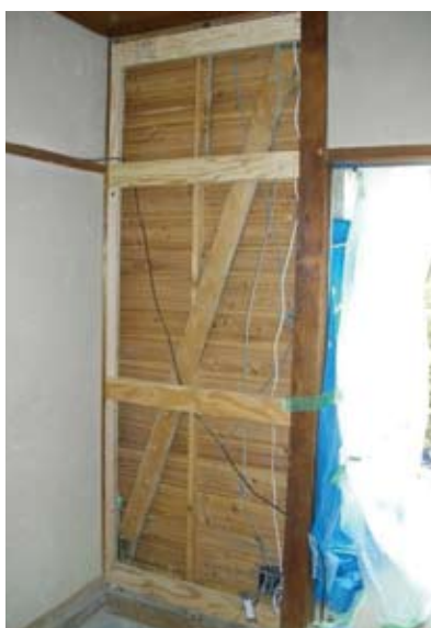
耐震改修の事例(壁の補強)
