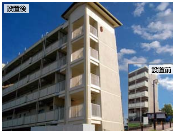
エレベーター設置を行った市営住宅
