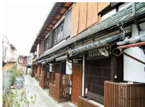
改修した京町家を活用した賃貸住宅
