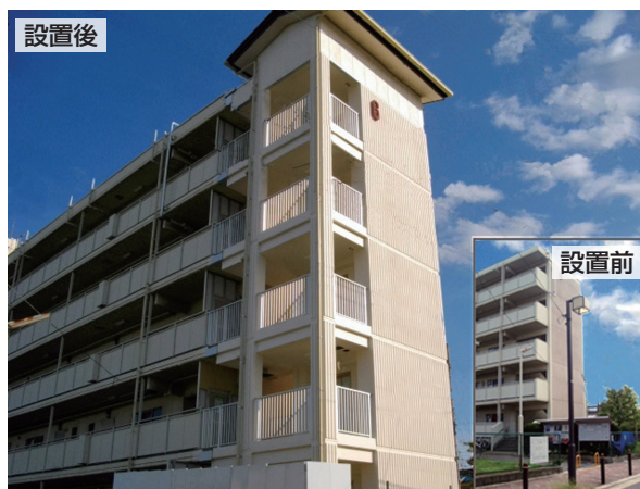
エレベーター設置を行った市営住宅
