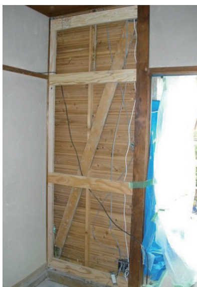
耐震改修の事例(壁の補強)
