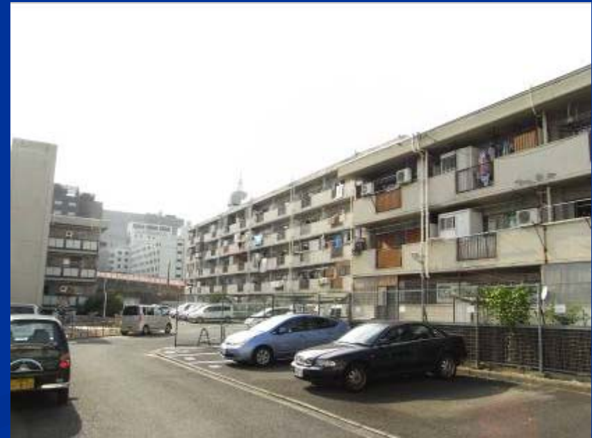
北部第一地区（23棟・26棟）
