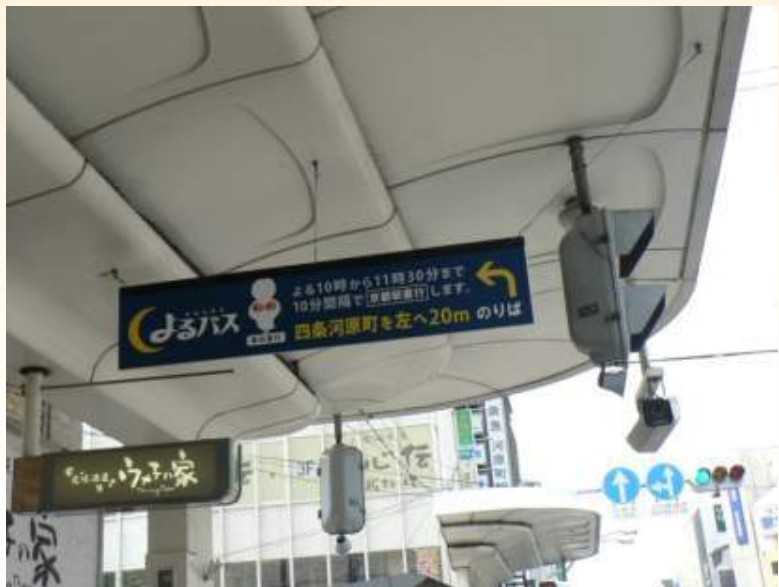
かわらまち・よるバス 案内標識(四条通歩道上屋に設置)
