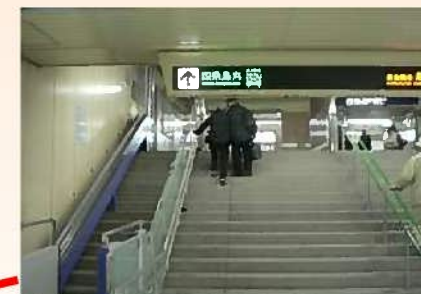
昇降機が設置
