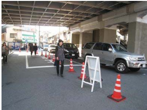
九条陸橋下の迂回誘導状況
