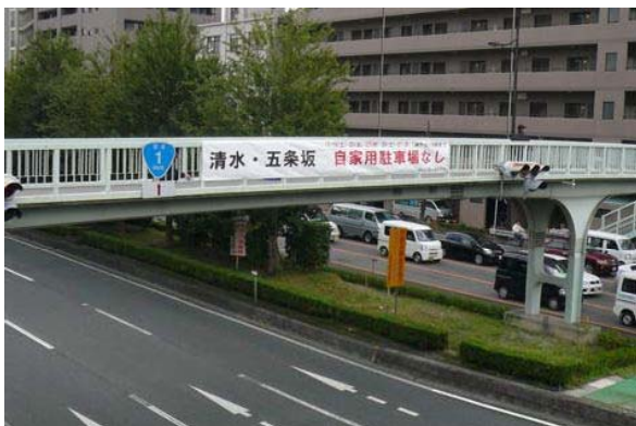
西鋸屋町横断歩道橋
