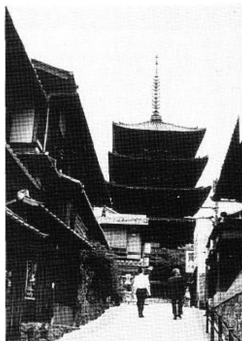
鴨東Ⅱ美観地区（第2種地域） 歴史的な建造物が並ぶ 八坂通付近
