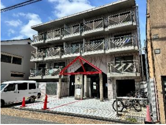
w14-1 4階建共同住宅。 セットバックして駐車場を配し、エントランスに高彩度色が使用されている例。(1988年建築)
