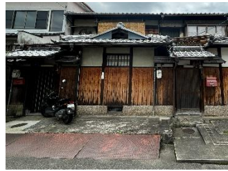
s14-1 2階建住宅。 土壁や板張りの自然素材が 使用されている。区間内で最 も古い建物。(1912年建築)
