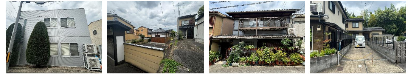
s03-1 2階建事業所。 区間に面した部分に高木を 植栽している例。(2005年 建築)
