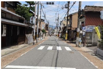
⑤N-pt09: B-1)伝統要素の割合 併用住宅(w19)の板張、軒庇、犬矢来、駒寄により伝統要素の割合が高まっている。
