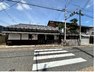
w19-1 1階建住宅。 塀が土壁・板張りであり、主屋も塗壁・板張り、建具木製。自然素材利用が路線内で最大。(建築年代不明)
