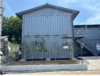
e20-1 2階建倉庫。 道路側に中高木の列植を設けている例。植栽の密度は小さい。(2025年建築)
