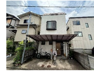
s02-1 2階建住宅。 セットバックしオープン駐車 場を設けた例。(1986年建 築)
