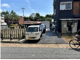
e10-1 1階建倉庫。 旗竿敷地に建ち、D/H最大(5.4)。建物越しに東福寺塔頭霊雲院の樹林が見える。(建築年代不明)
