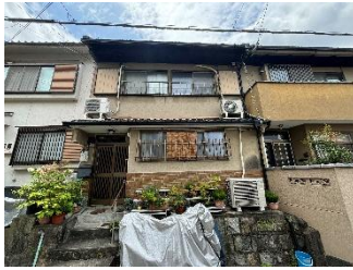
s07-1 2階建住宅。 石積擁壁が設けられている。 (1926年建築)
