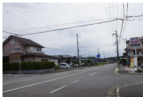
幹線道路沿道のゆとりある敷地で構成される町並み
