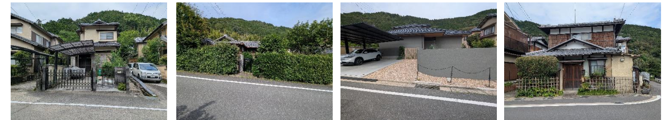
e02-1 2階建住宅。間口幅が比較的小さく、入口角に低木のみ植えられている。植木鉢に中木が植わる。(1981年建築)
