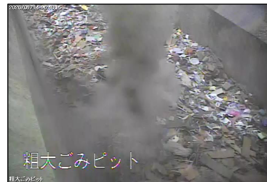
粗大ごみピット火災警報発報時
