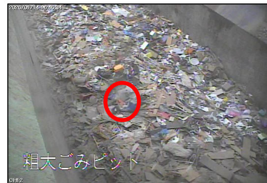
粗大ごみピット発煙時
