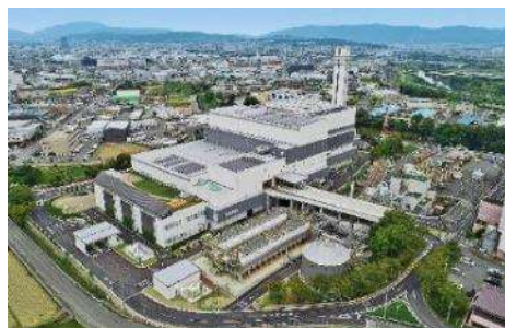
南部クリーンセンター
