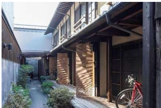
改修後の長屋
