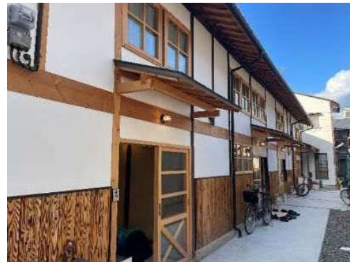
改修後の外観
