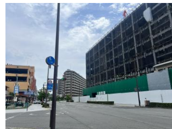
建設が進むマンション
