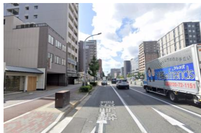
E-pt24付近から南方向 電線類地中化の状況。地中化に伴う地上機器。
