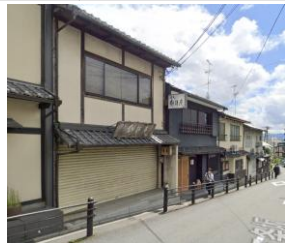
pt4から西方向 階段状に連なる軒庇
