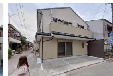
No.41【新築】 2階建の戸建住宅。切妻。セットバックして駐車スペースとする。東西の通りを正面とする。
