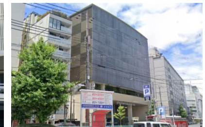
No.105【新築】 9階建の商業施設・ホテル。壁面は道路に沿って曲がり、4階以上は低彩度色の格子状。
