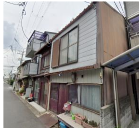
No.82 外壁全体がサイディングで覆われている。
