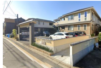
No.34【新築】 2階建集合住宅。寄棟。大きくセットバックする。瓦葺の門と低い塀を設ける。
