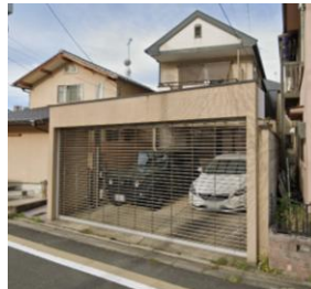
No.79【新築】 2階建の戸建住宅。駐車スペース前面にゲートを配す。
