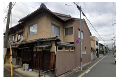
No.23 東西道路に正面を向ける。総二階。格子窓等が見られる。
