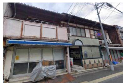
No.14,12,10 庇部の除去又は看板で覆われる(No.14,12)。
