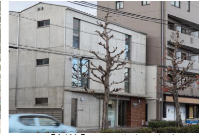
No.24【新築】 3階建の事務所。勾配屋根・コンクリート打ち放し。1階にコンクリート製水平庇あり。
