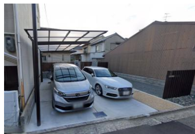
No.6【新築】 戸建住宅。大きくセットバックし、前面に駐車スペースを配す。カーポートあり。
