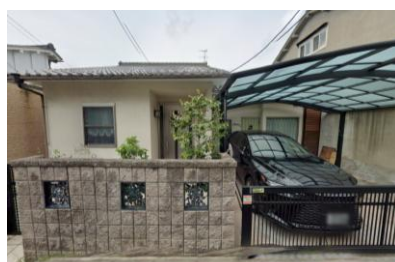
No.34【新築】 平屋建の戸建住宅。瓦屋根。一部をセットバックしカーポート設置。
