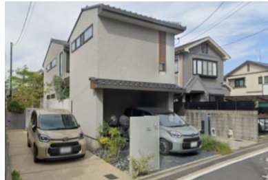
No.29【新築】 2階建の戸建住宅。寄棟(変形)・庇あり。前面1階を駐車スペースとする。
