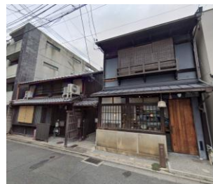
No.98,99 修理・改修等による店舗利用(No.93)
