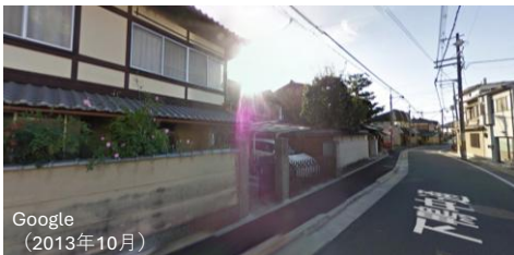
前面への駐車場配置により壁面の連続性が損なわれている。
