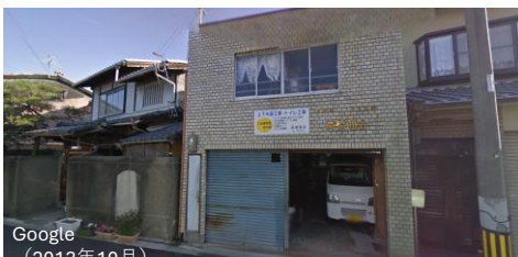
建物のセットバックにより隣接する町家の妻面が表れている。
