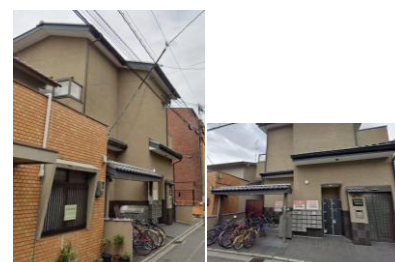
No.68【新築】 2階建集合住宅。庇あり。駐輪スペースの瓦葺の門設置。軒裏の白さが際立つ。
