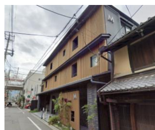
No.81【新築】 3階建ホテル。2・3階のファサード全面に格子を使用。インナーバルコニーあり。
