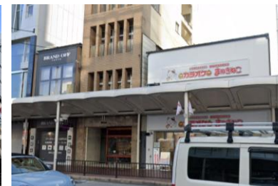
No.77,79【新築】 いずれも2階建の店舗。1・2階全面に庇・格子と漆喰・真壁風の外壁あり。
