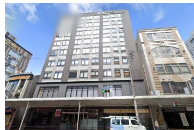
No.52【新築】 9階建のホテル。2階の高さで軒を設けてデザインを変えている。
