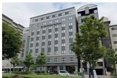
No.40【新築】 9階建ホテル。外壁色は上層階へと明度を高くする。1階・2階に水平ラインが配される。
