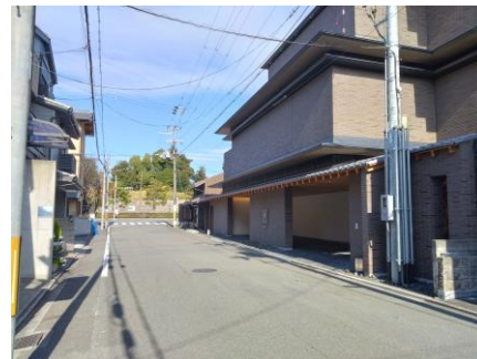
敷地を合併して建設された宿泊施設
