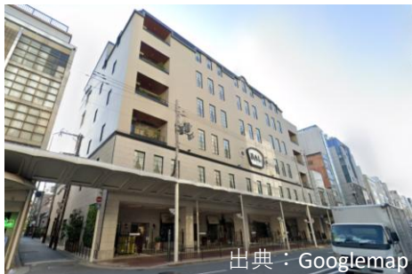
新景観政策実施以降に建設された商業施設
