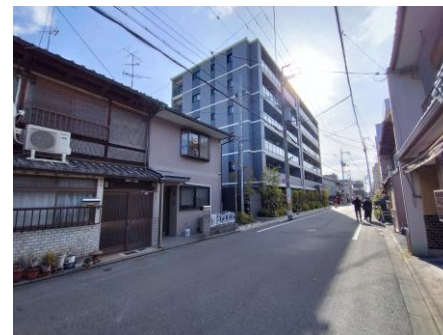
低層住宅と並ぶ中規模マンション
