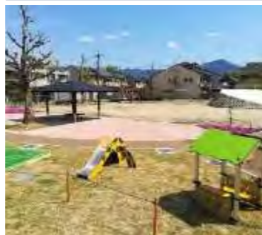
公園再整備 老朽化した身近な公園の再整備
