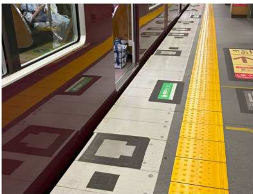
整備後(3 号線ホーム段差・隙間の縮小状況)
