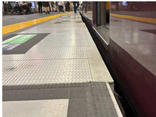
整備後(1 号線ホーム段差・隙間の縮小状況)
