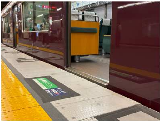
整備後(1 号線ホーム段差・隙間の縮小状況)
