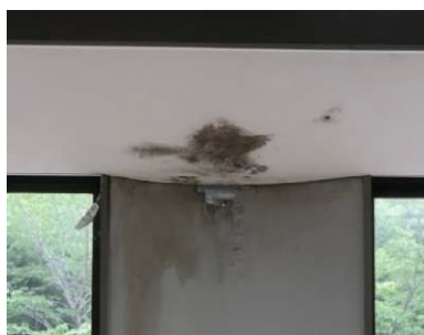
図 15 雨漏り写真
