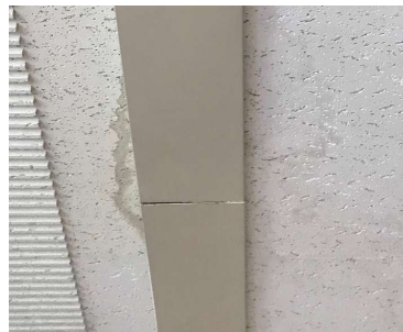
図 16 雨漏り写真
