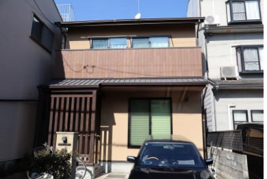
No.71 2階建の戸建住宅。玄関部に格子風デザイン、手摺壁に板張り風デザインあり。
