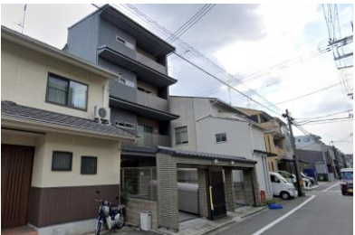
No.238 4階建のマンション。各階前面にバルコニーと庇を、敷地際に塀・門を設置。外壁仕上げはサイディングタイル。
