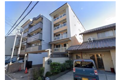
No.205 5階建のマンション。各階前面にバルコニー、1・2階に庇、敷地際に塀・門を設置。
