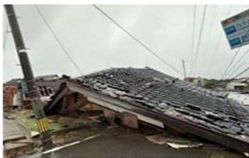
倒壊した木造建築物
