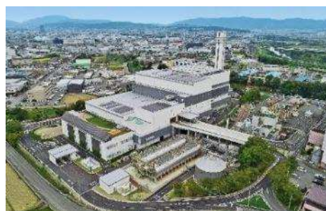
南部クリーンセンター
