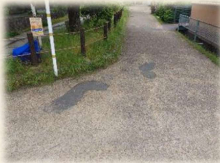
(舗装済区間の状況写真)
