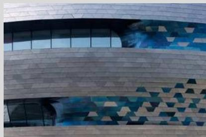
ファサードには新技術の「デュアルカラーINCO技術」を中国で初めて大規模に採用。天候や腐食に対する耐性を高め、寿命を延長するとともに、塗装なしでステンレス鋼に繊細な質感と色調を付与している。
