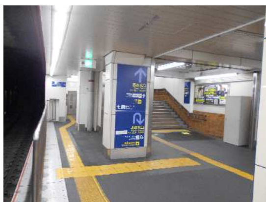
西改札口 EV 設置
