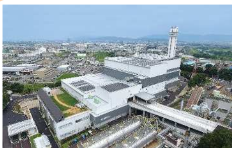
南部クリーンセンター第二工場 (令和元年度稼働)
