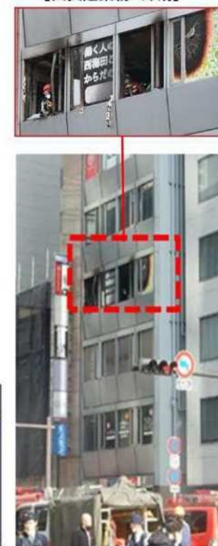
【火災建築物 外観】
