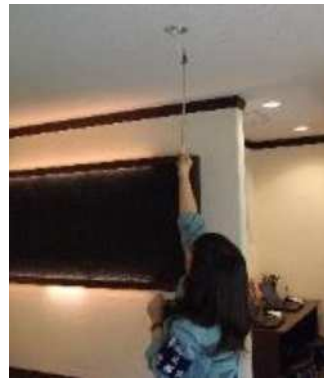
査察の様子（非常用照明点灯確認）
