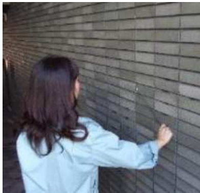
査察の様子（外壁タイル打診調査）
