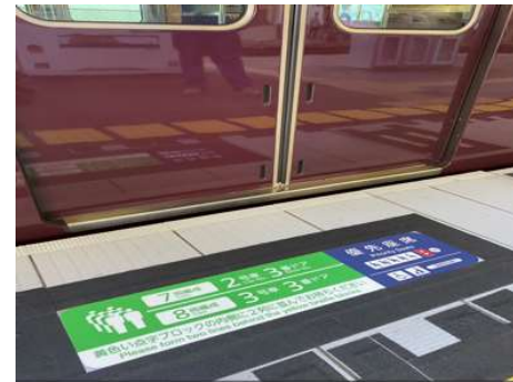
整備後(段差と隙間が縮小)
