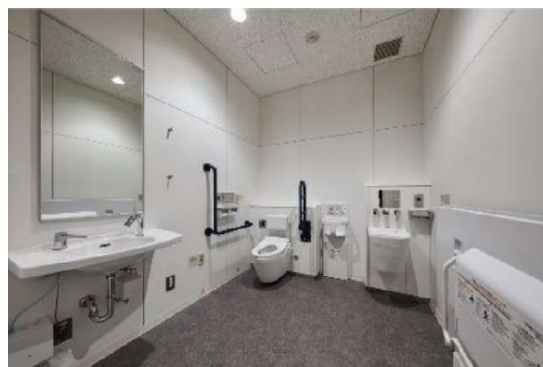
・オストメイト対応設備を設けた バリアフリースイレ
