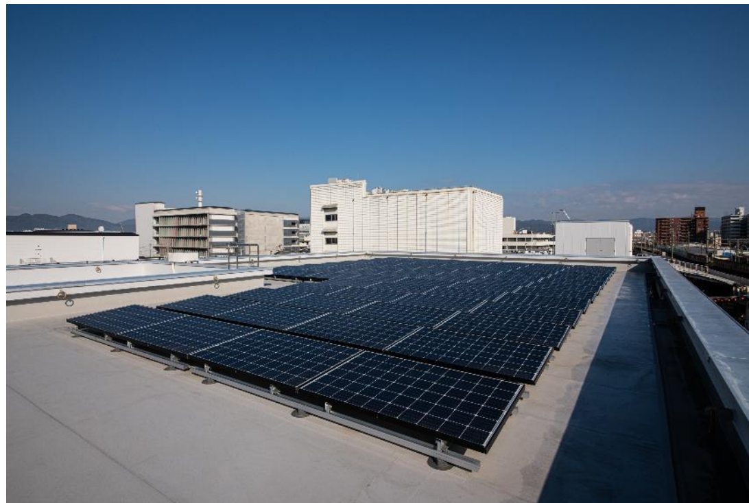
京都市中央卸売市場 新水産棟
