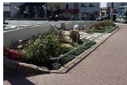
九条大石橋交差点北西角に 整備した雨庭
