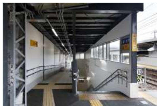
④・淀屋橋(大阪)方面ホームから改札へ向かう スロープ
