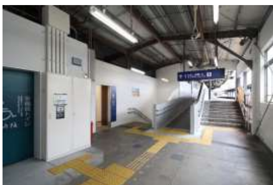
①・整備したバリアフリースペース ・出町柳(京都)方面ホームへ向かうスロープ
