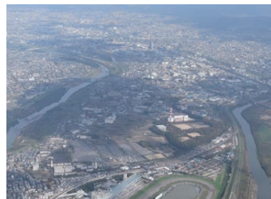
■土地区画整理事業（伏見西部地区）
