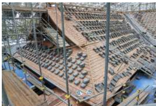
屋根工事（土居葺復旧完了・瓦配り）
