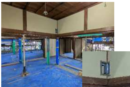
鉄骨ラーメン補強（桁組み部・内部）
