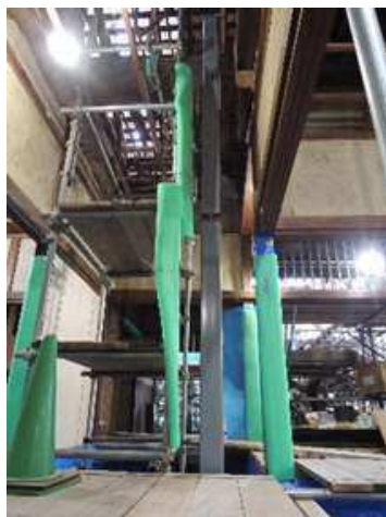
鉄骨柱補強(150mm角)
