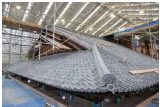
屋根工事（1階瓦葺完了）
