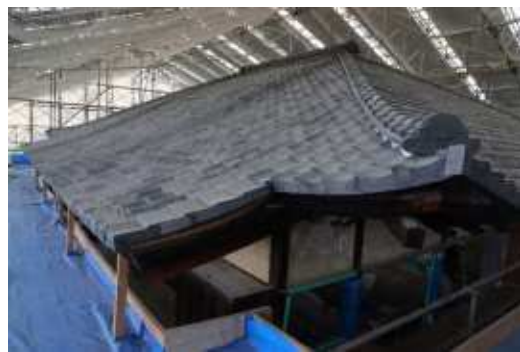
屋根工事（2階瓦葺完了）
