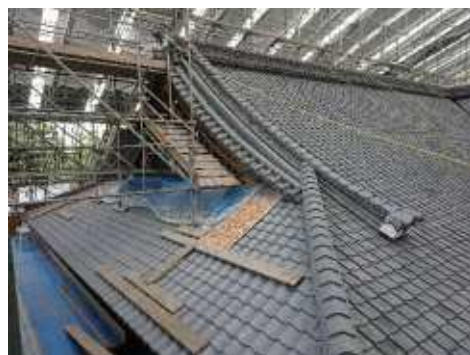
屋根工事（瓦葺完了）
