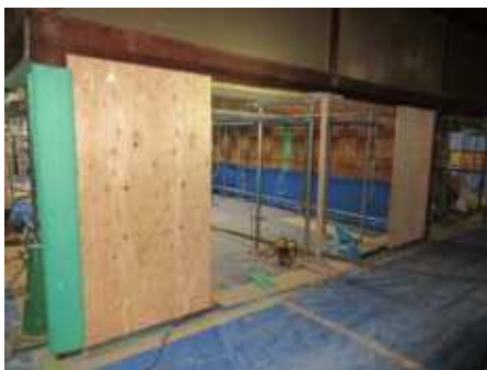
建具補強の仮建て込み
