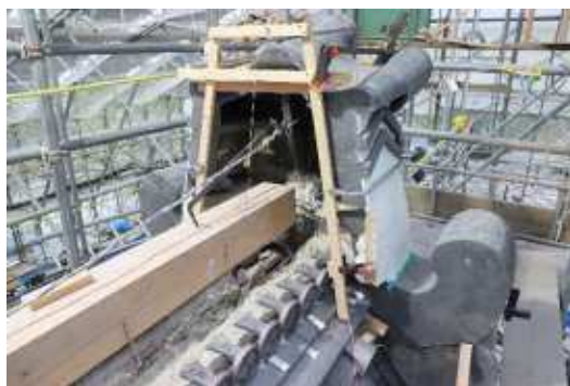
屋根工事（鬼瓦据え付けの様子）
