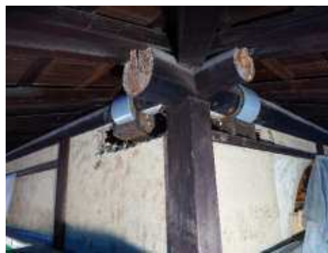
同（桁組み部・外部）
