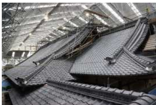
屋根工事（瓦葺完了）
