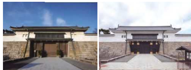
修理前 修理後
