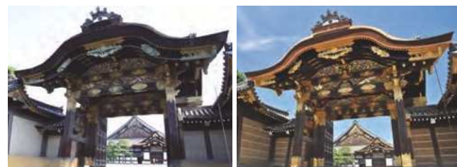
修理前 修理後
