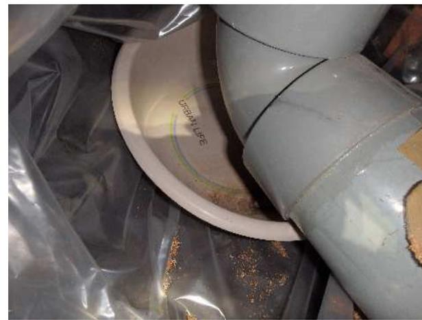
排水管の接合部からの漏水
