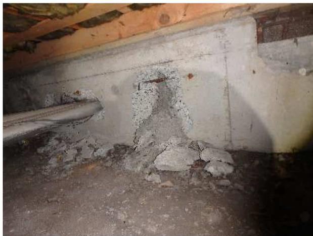
基礎の鉄筋露出（コンクリート爆裂）
