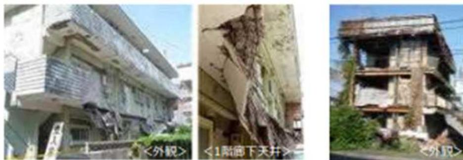
2階の廊下部分が崩落した事例
