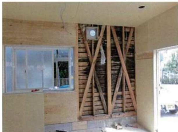
上部バルコニー床からの雨漏りにより壁内が腐朽
