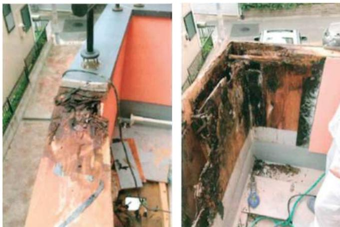
バルコニー手すりの笠木やジョイント部から雨水が浸入し、手すり内部が腐朽
