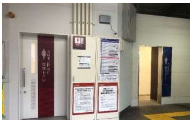
①新設したバリアフリートイレ(工事中は女性トイレとして使用)及び男性トイレ
