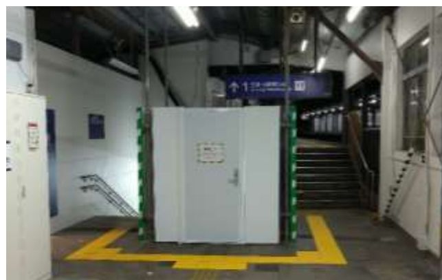
②改札口から上りホームへ向かう階段及び地下道に至る階段（スロープ工事中）
