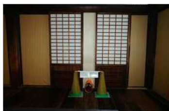
二の丸御殿及び展示収蔵館に換気ダクトの設置
