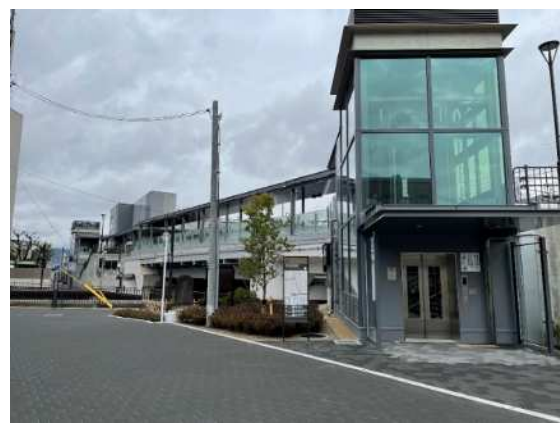
西大路通上空で東西をつなぐアクセス通路
