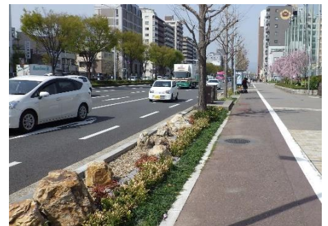
堀川通に整備した雨庭
