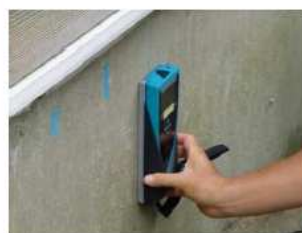
基礎配筋の調査
