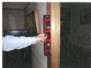
水平器による柱の傾きの計測
