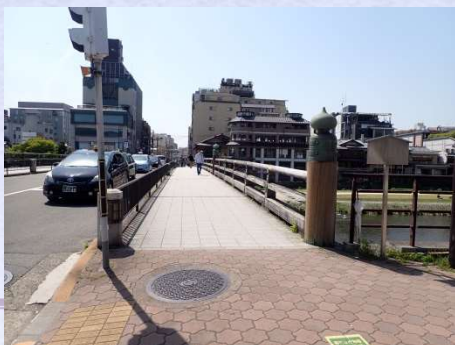
三条大橋路面状況
