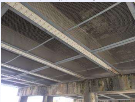
三条大橋桁下面状況
