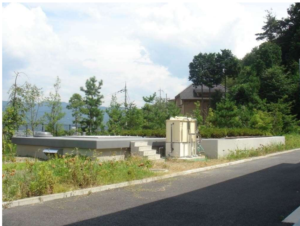
山科土壤脱硝施設
