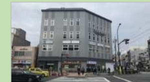
工事完了後の西院駅（阪急）
