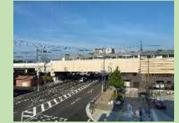
阪急京都線（洛西口駅付近）連続立体交差化事業
