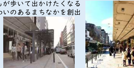
整備後の四条通
