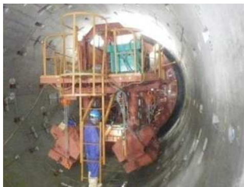
施工中の雨水幹線の内部
