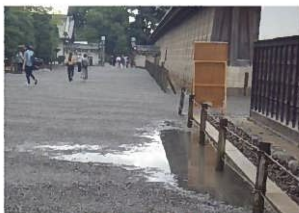
雨天後の通路（休憩所西側付近）
