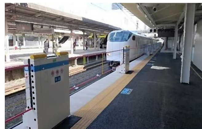
可動式ホーム柵（写真：高槻駅）
