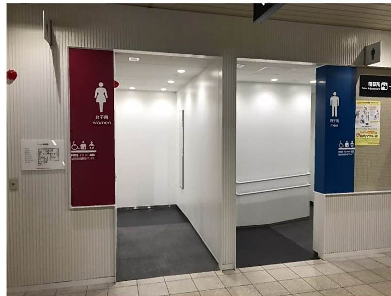
トイレ前アプローチの段差解消 (写真：竹田駅北駅舎)
