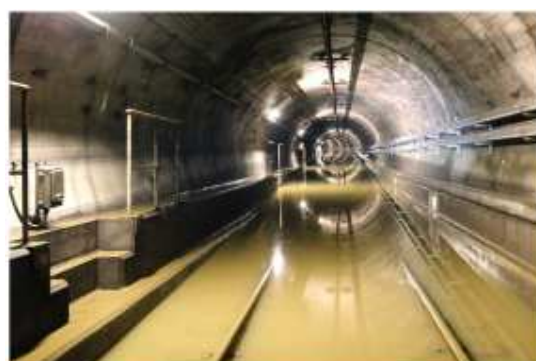
平成 25(2013)年の台風 18 号により浸水した地下鉄東西線のトンネル部
